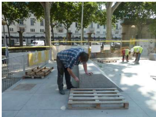
Repàs i arrodoniment d'arestes d'obstacles de granit un cop finalitzada la col·locació i paviments.
