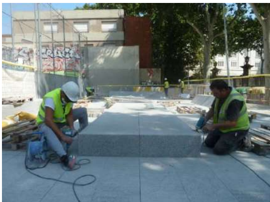
Repàs i arrodoniment d'arestes d'obstacles de granit un cop finalitzada la col·locació i paviments.
