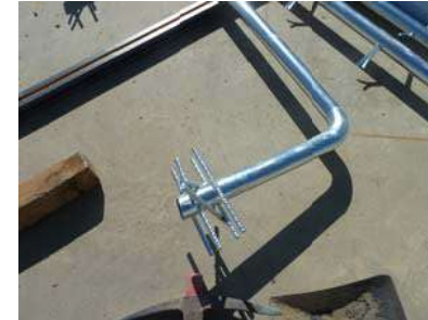
Detall Tipus d'Ancoratges de Rail
