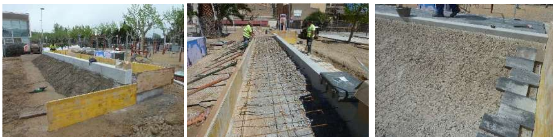
1. Vorera a lloc. 2. Connectors tac químic a granit per formigonat. 3. Presentar peces abans de col·locar.
