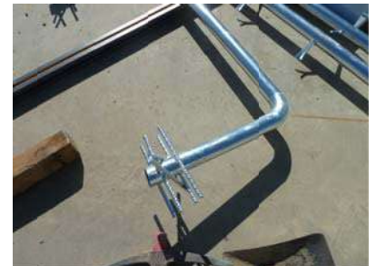
Detall pota del rail amb ancoratges i connectors
