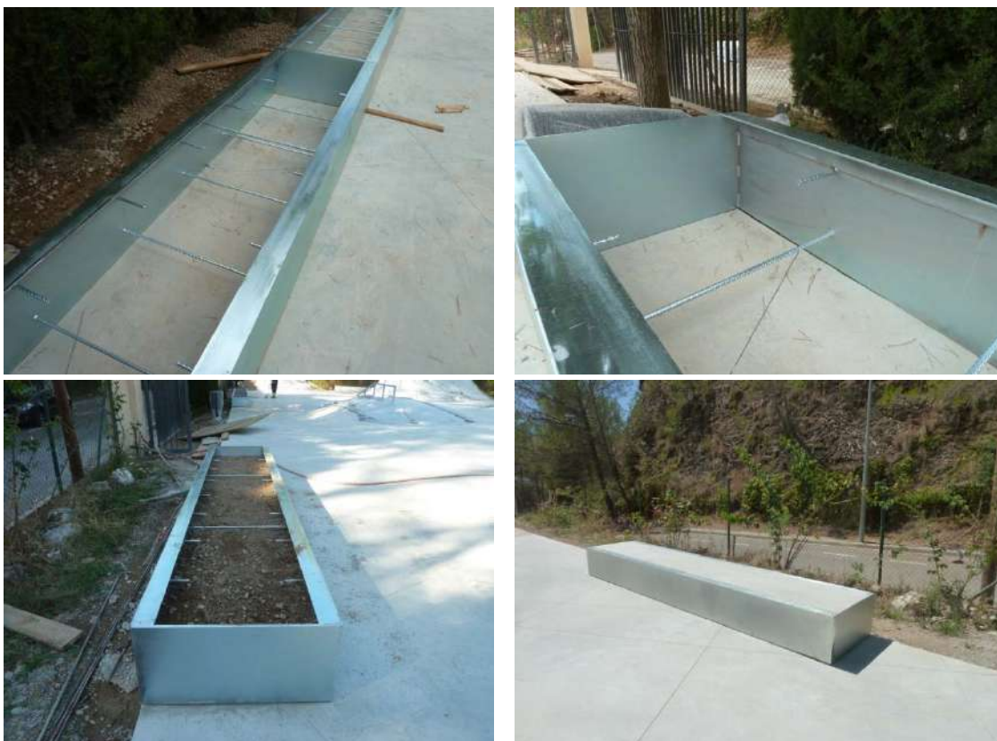
Soldadura llisa i continua entre l'angular i la vora dels calaixos "M". Connectors, etc. Reomplert i Acabats
