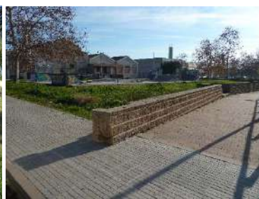
Accés i urbanització existent
